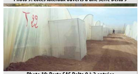
Photo 10: Porte SAS Delta 9 à 2 entrées
